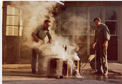
Neue Radreifen aufziehen
